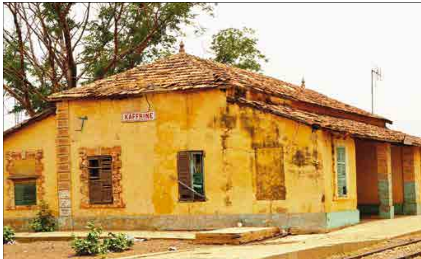
Gare Ferroviaire de Kaffrine
